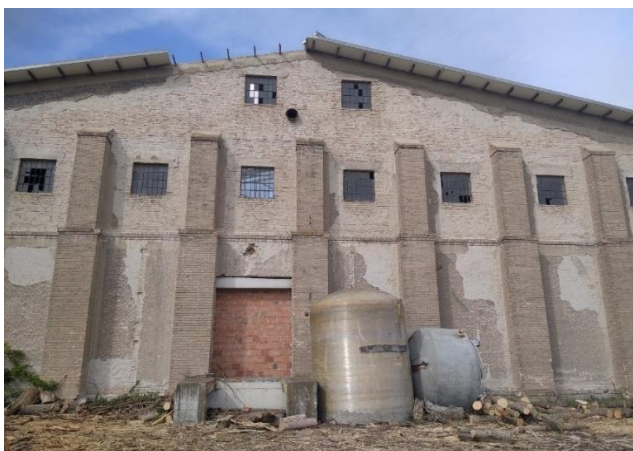
Sl. 33. Zgrada bivšeg skladišta šećera
