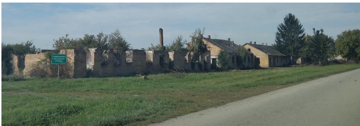
Sl. 25. Napuštene stambene zgrade u Radničkoj ulici u Kneževu
