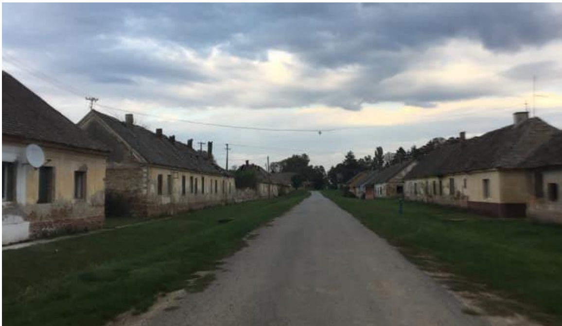
Sl. 24. Napuštene stambene zgrade u Graničarskoj ulici u Kneževu
