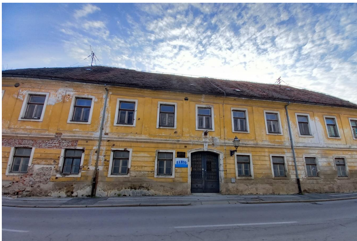
Sl. 18. Današnje stanje nekadašnje zgrade KAMOD-a
