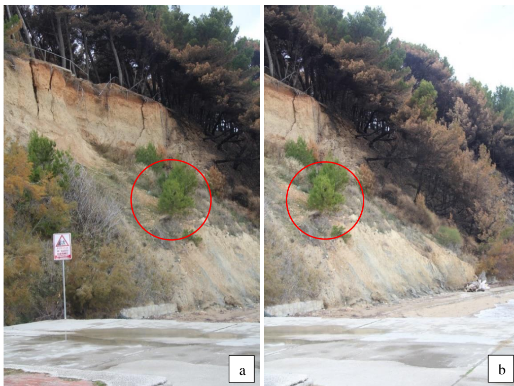
Slika 34. Područje odrona na dijelu klifa Duilovo uz betoniranu plažu, prosinac 2017.
