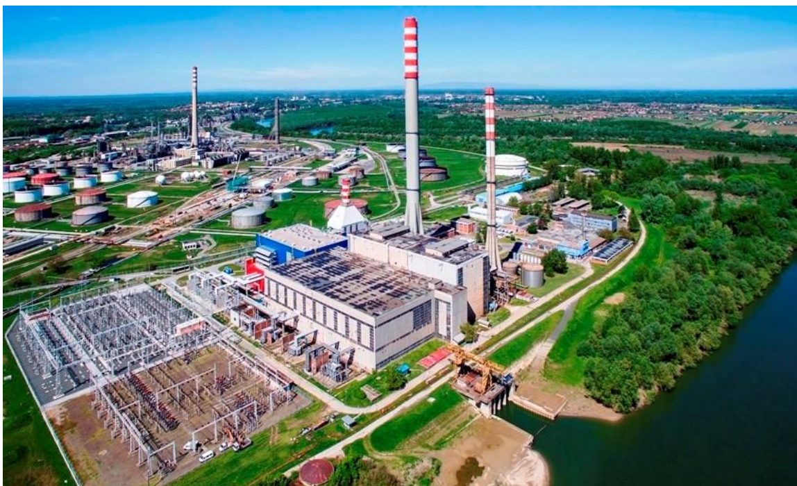
Sl. 2. Termoelektrana Sisak
