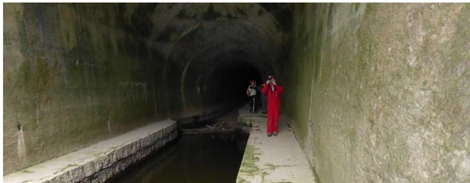
Slika 2. Prikaz hidrotunela iznutra.
