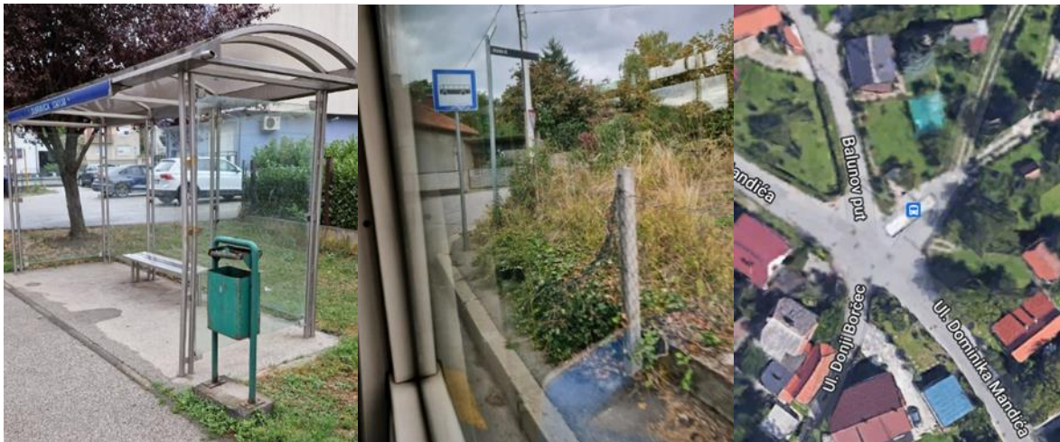
Sl. 10., 11., 12. Standardizirano stajalište ZET-a, neadekvatno izvedeno stajalište i okretište autobusa linije 137
