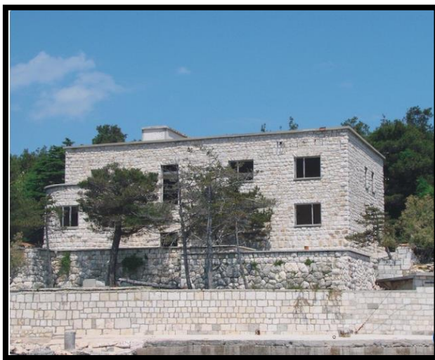
Sl. 35. Posjetna zgrada
