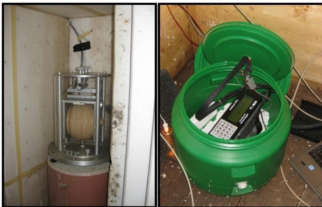
Slika 1.4 – Lijevo: Ovjesheni ( engl. suspended ) DIDD senzor koji mjeri na V-pilaru u variometarskoj kući. Oko senzora je postavljena izolacijska kutija kako bi se osigurala bolja temperaturna stabilnost. Desno: Elektronička jedinica DIDD magnetometra (GSM-19FD).
