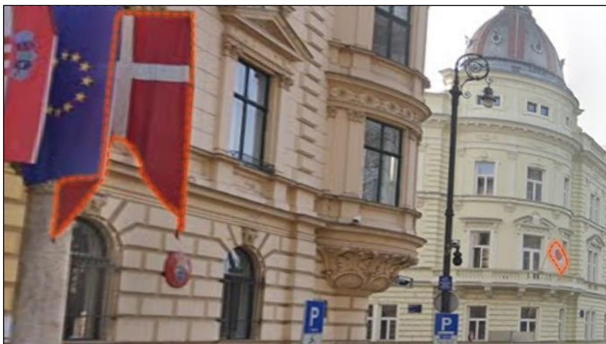
Slika 2. Dansko (prva zgrada u nizu) i japansko (druga zgrada u nizu) veleposlanstvo u Zagrebu, izvor: Google Maps, 2023
