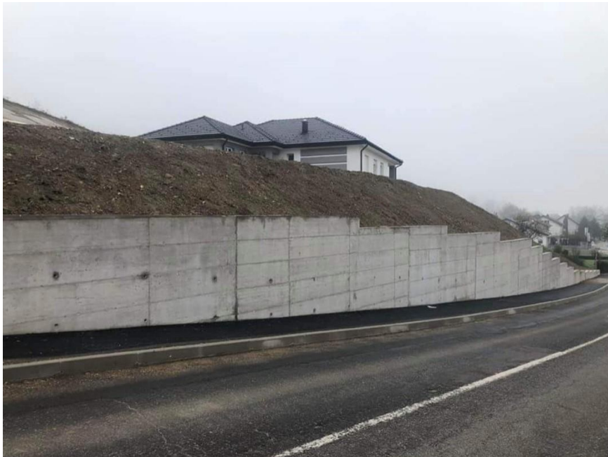
Sl.19. Završena izgradnja armirane škarpe za zaštitu aktiviranog klizišta u Krapinskim Toplicama
