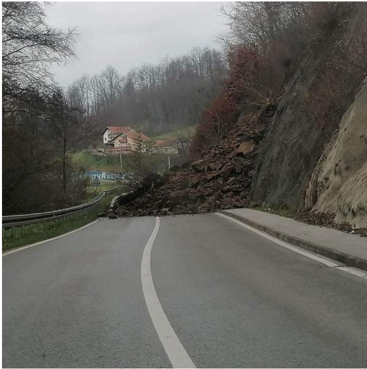
Sl.13. Pucanje zaštitne mreže te odron kamenja i blata na DC206 Pregrada – Hum na Sutli kod mjesta Kostel
