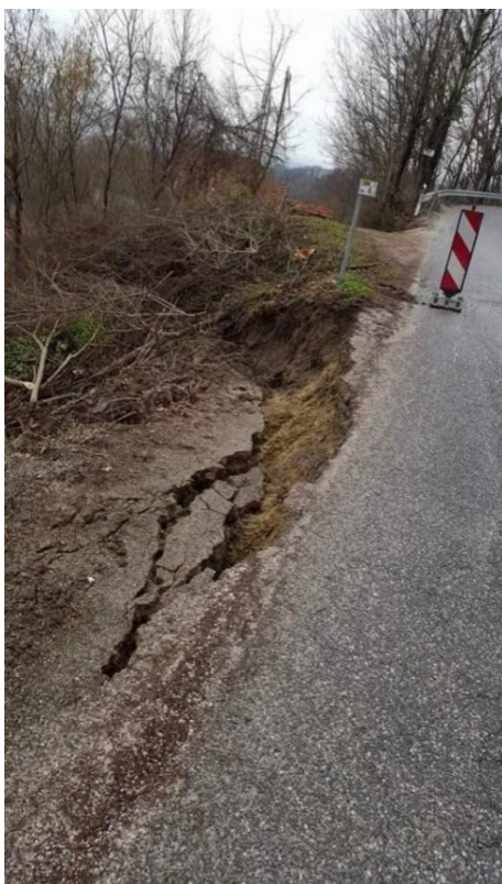
Sl.14. Odron ceste te aktivacija klizišta ispod na lokalnoj cesti kod sela Matenci, Donja Stubica
