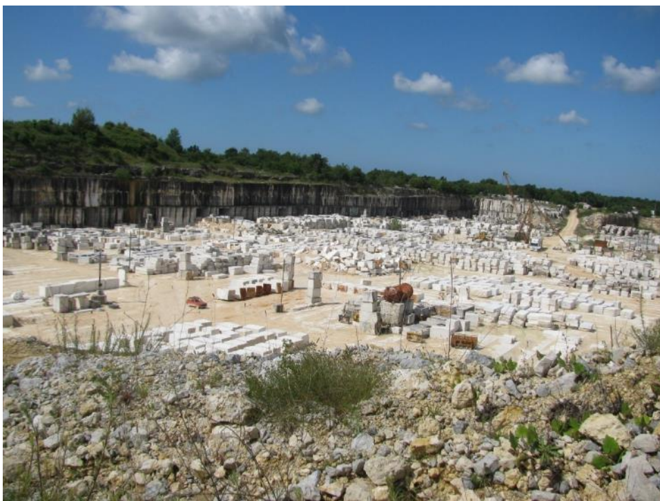
Slika 10. Kamenolom Kanfanar (fotogr. M. Martinuš)
