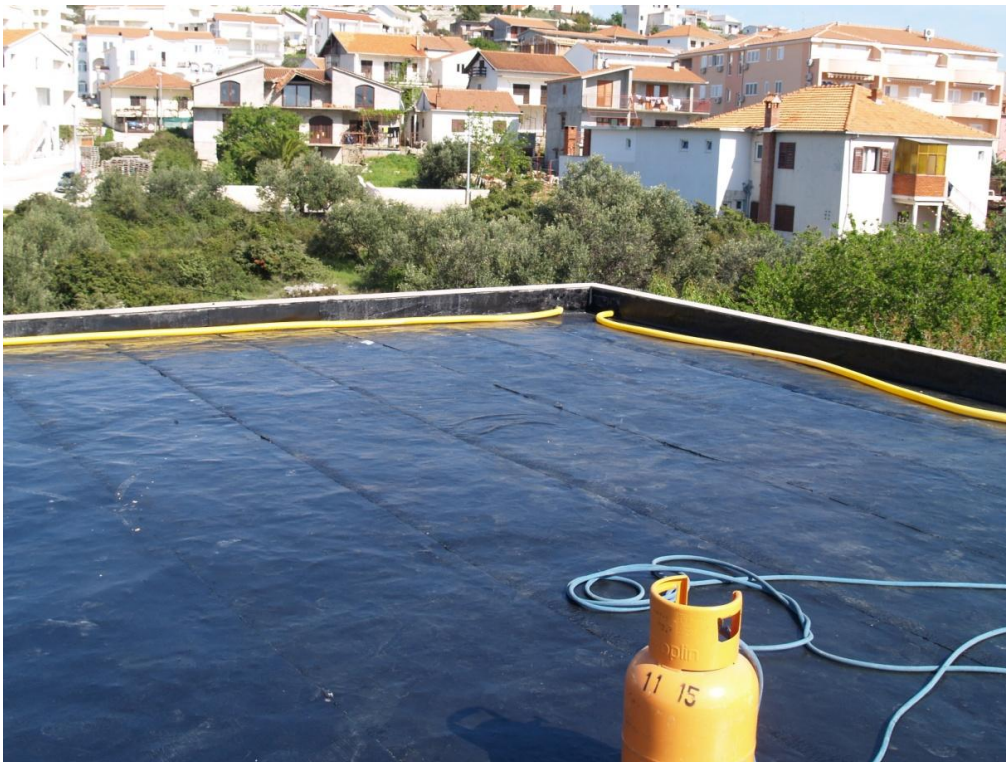
Slika 9. Postavljanje ljepenke za izolaciju krova
