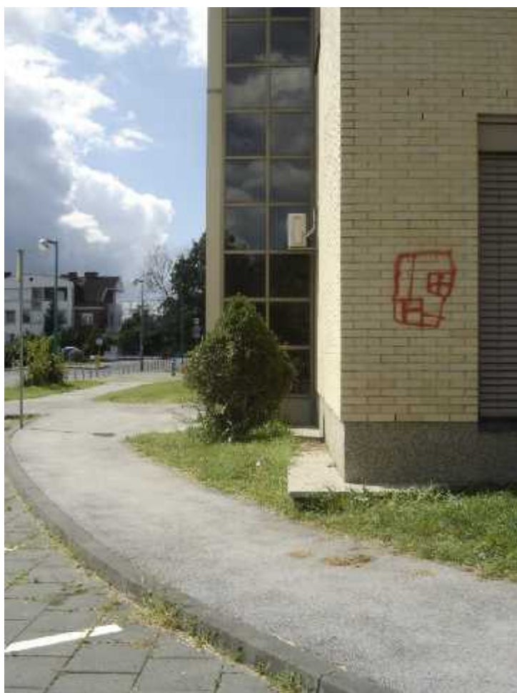
Slika 46. Pogled sa isto ne strane iza zgrade PMF-a ( Taxus baccata )
