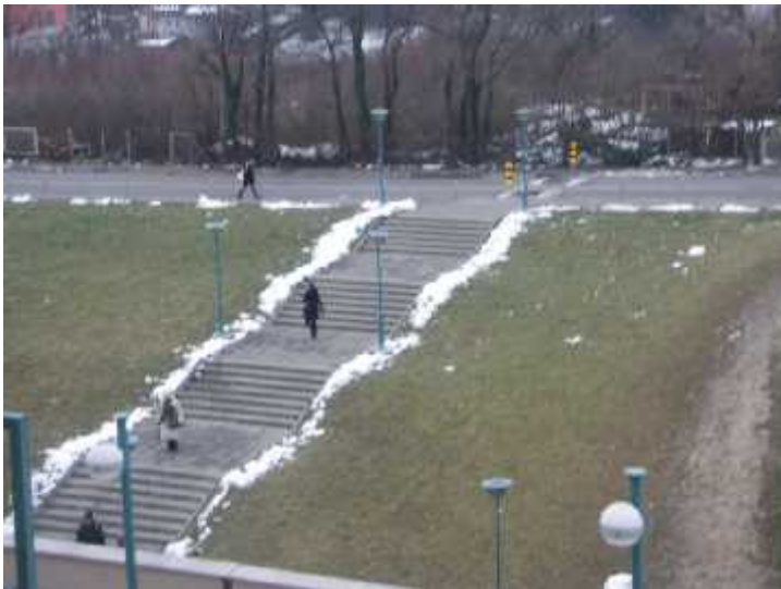
slika 33. Pogled sa SI strane na ulicu Horvatovac
