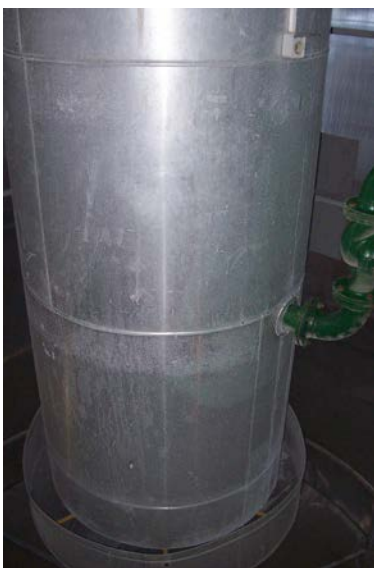
Slika 6. Izvor (bušotina) termalne vode (Vlastita fotografija)
