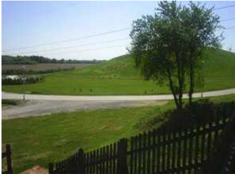
Slika 4. Sanirano odlagalište otpada „Mraclinska dubrava“ ( http://www.mzopu.hr )
