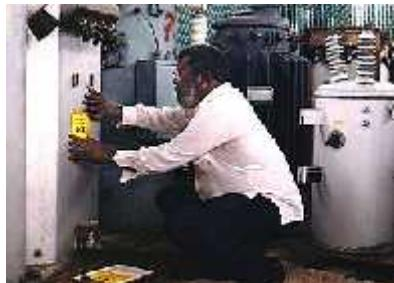
Slika 4.: Označavanje električnog transformatora koji sadrži PCB
