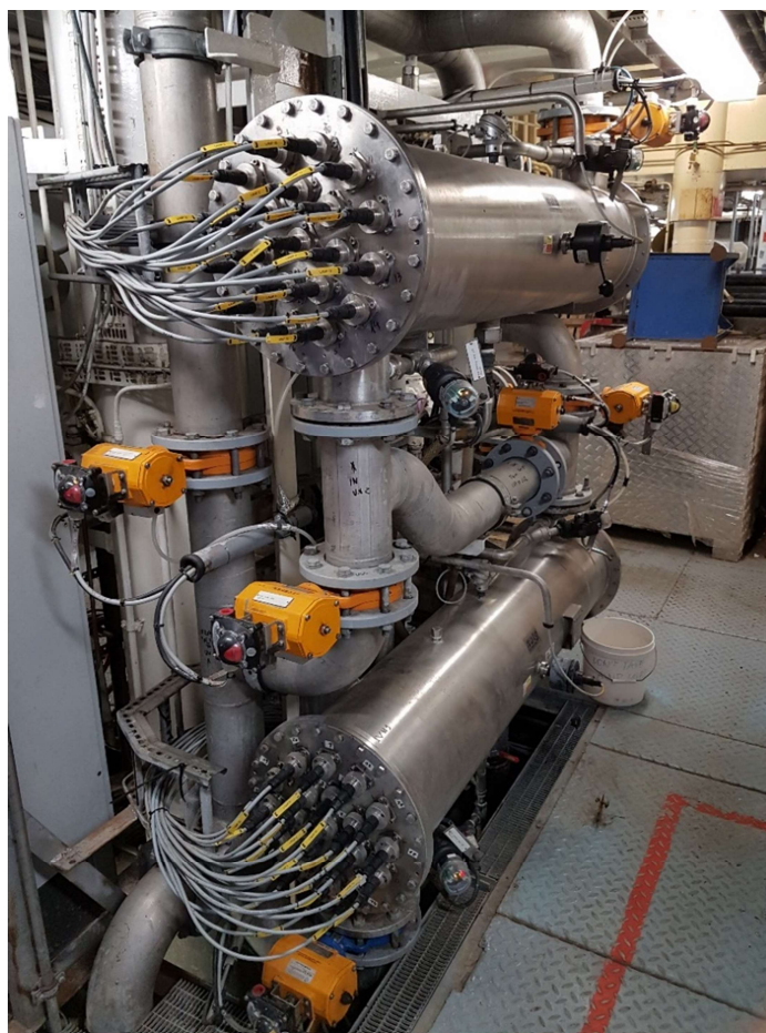
Slika 6.12. UV model za dezinfekciju vode; fotografija: Nikola Marvučić
