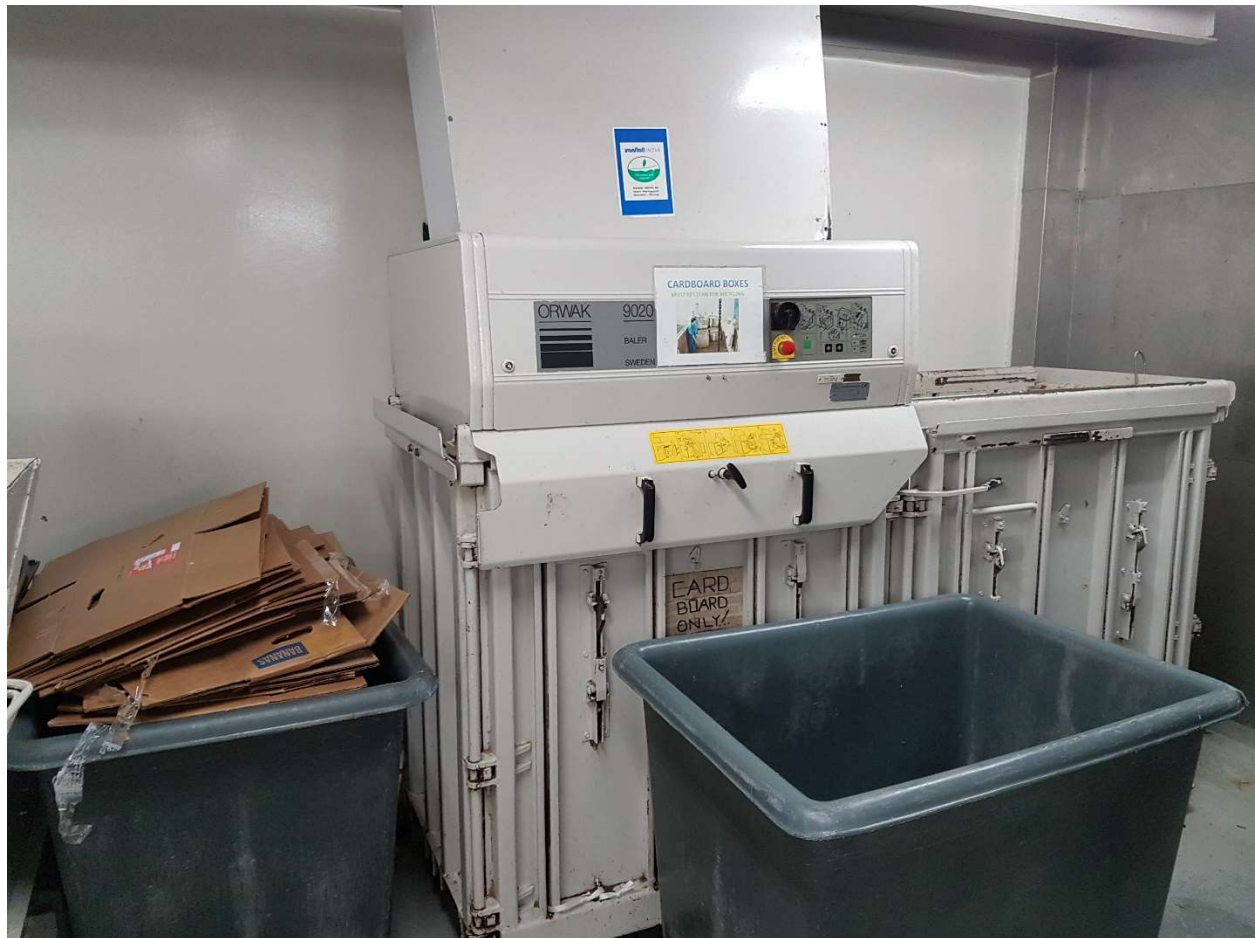
Slika 4.17. Uređaj za prešanje kartona; fotografija: Nikola Marvučić
