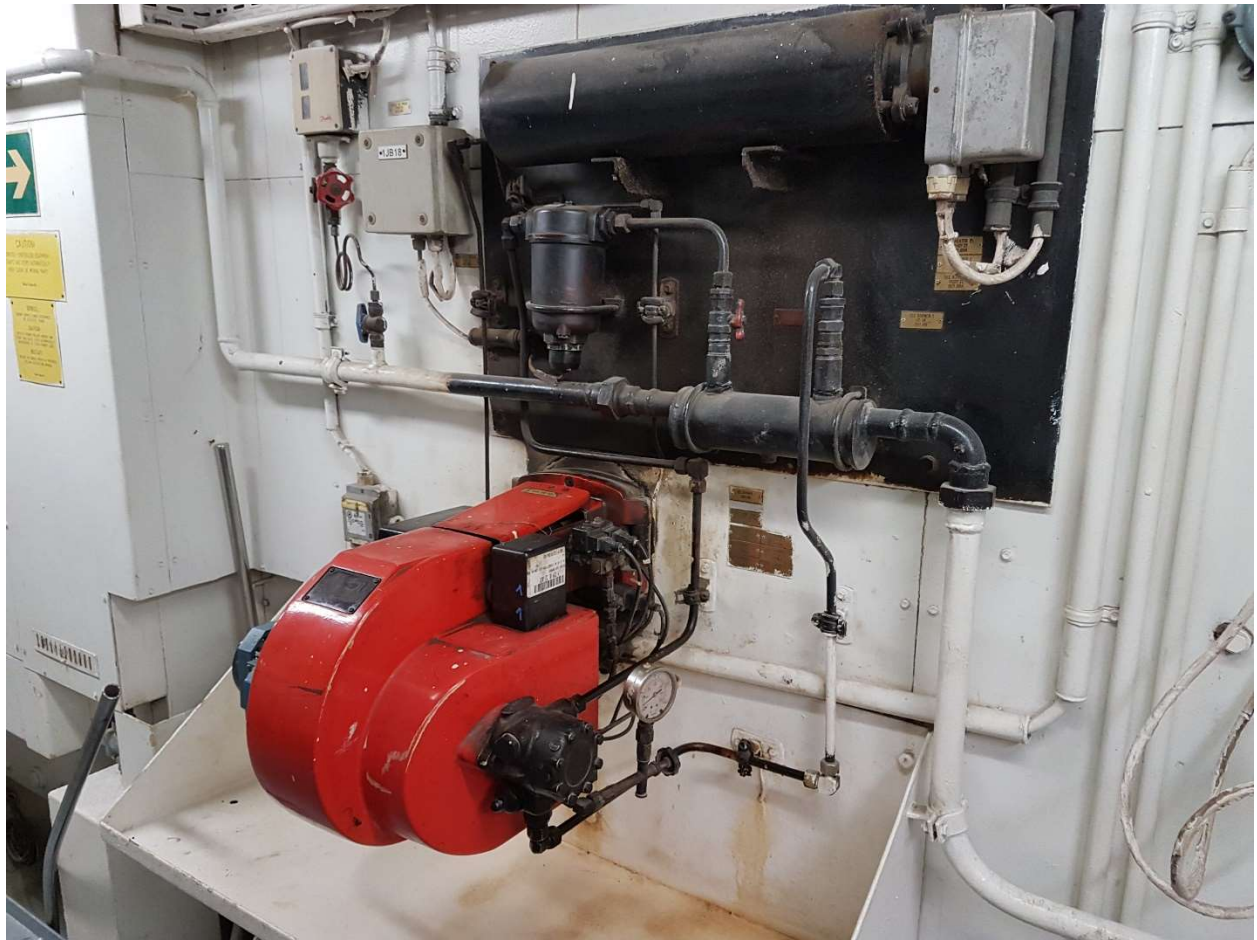
Slika 4.5. Sekundarna spalionica; fotografija: Nikola Marvučić
