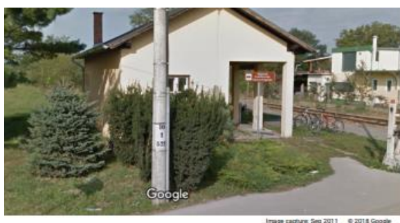
Sl. 11. Željeznička stanica u Dunjkovcu 2011. godine prije uređenja Izvor: Google Street View, 2011
