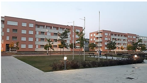
Sl. 12. Dvije neuseljene stambene zgrade
