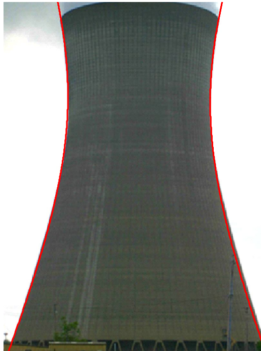
Slika 5.1.1.8. Rashladni toranj nuklearne elektrane
