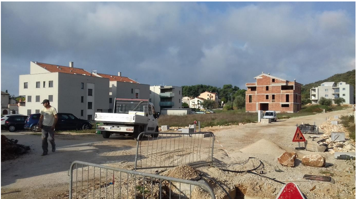
Sl. 21. Izgradnja novog stambenog naselja Mondelako Izvor: Snimio autor (8. 11. 2018.)
