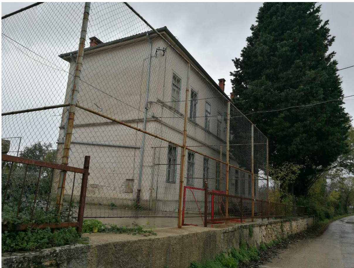
Sl. 23. Zgrada nekadašnje područne škole u naselju Mali Vareški
