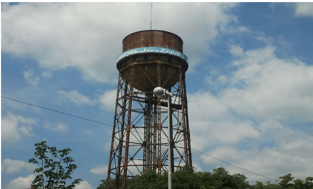
Sl. 17. Zaostala infrastruktura TŽV Gredelj na lokaciji Trnjanska-Strojarska (12. srpnja 2014.) Izvor: vlastita fotografija
