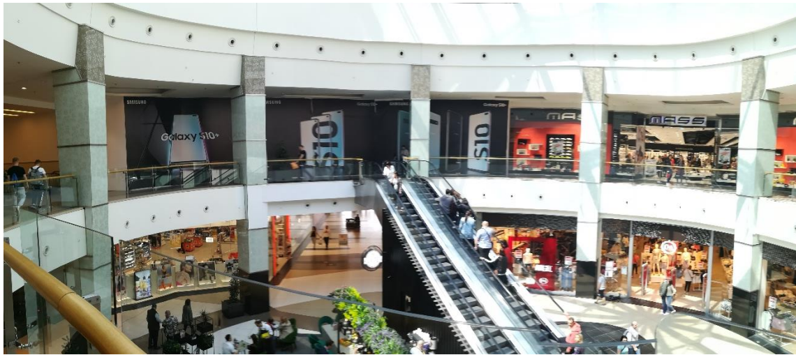
Sl. 61. Dio trga Istra u procesu rekonstrukcije (svibanj, 2019)
