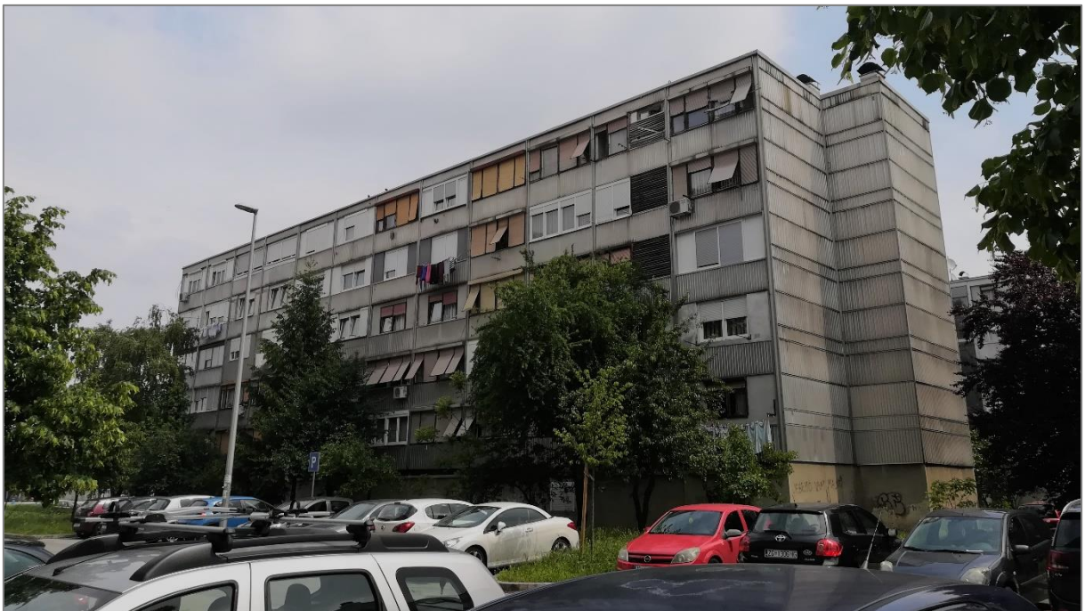
Sl. 48. Jugomontova stambena zgrada u Remetinečkom gaju (18. 05. 2019.)
