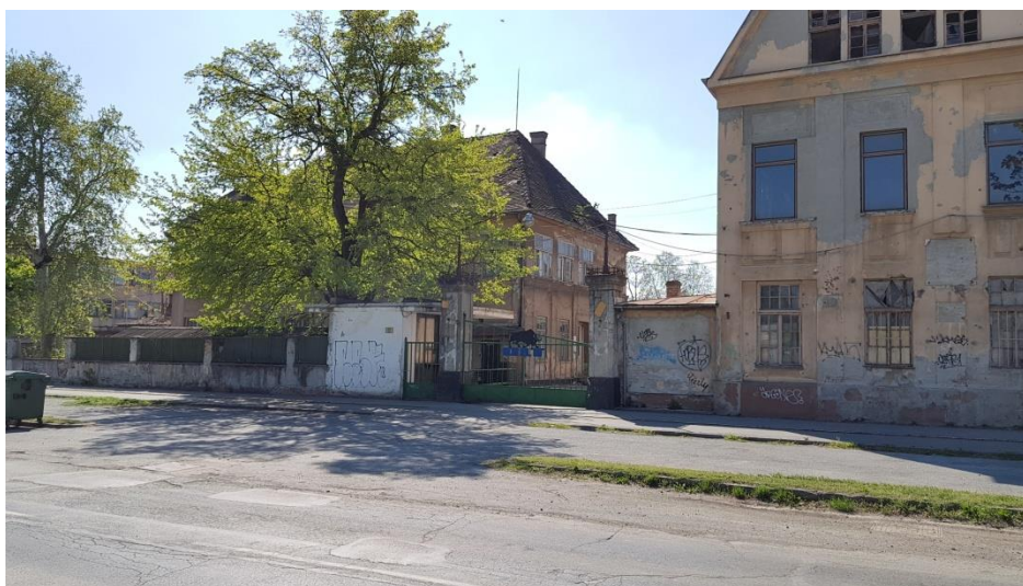
Sl. 27. Ulaz u napuštenu tvornicu OLT – Osječka ljevaonica željeza Snimio: Mislav Zemljak (19. 4. 2019.)
