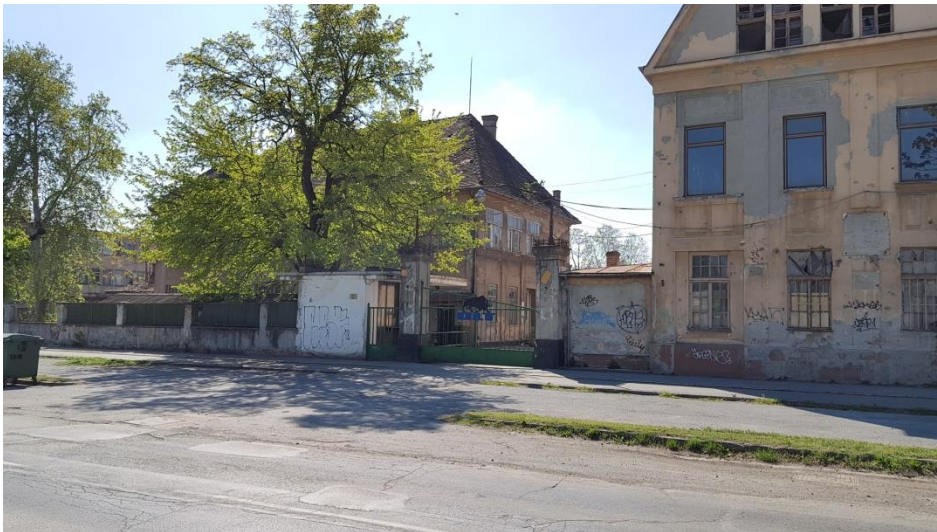
Sl. 27. Ulaz u napuštenu tvornicu OLT – Osječka ljevaonica željeza Snimio: Mislav Zemljak (19. 4. 2019.)
