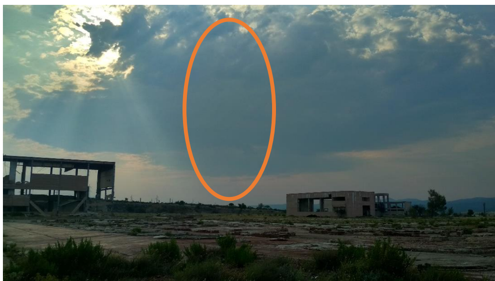
Slika 7. Ruševine i pustoš kompleksa Jadral (narančastom elipsom označen nekadašnji smještaj dimnjaka), 24.8.2019.
