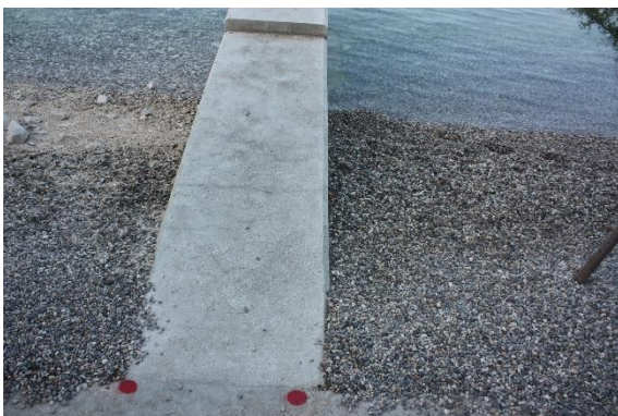
Slika 28. Zapunjenost sedimentom do razine šetnice na DRN (2.7.2018.).
