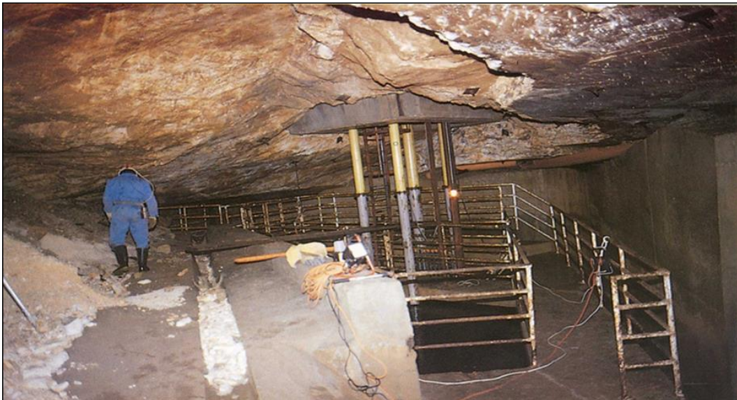
Sl. 20. Vodozahvat Tunel Učka
