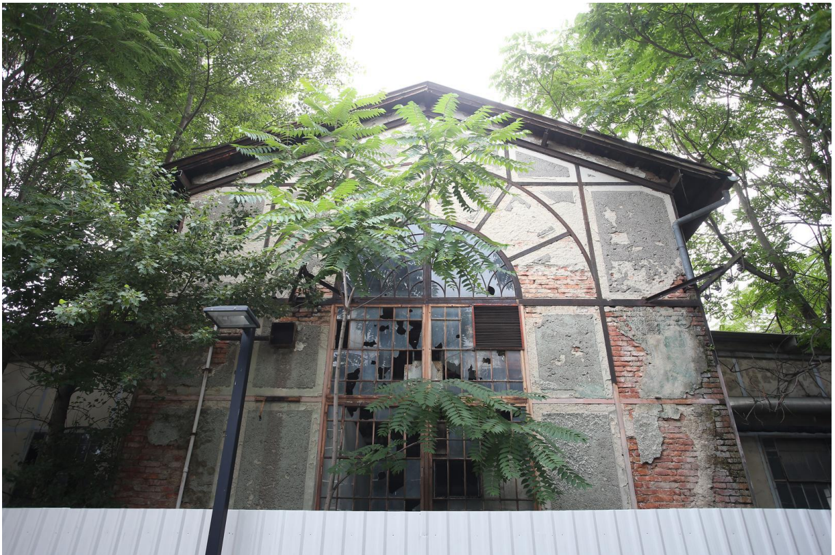
Sl.15. Pogonska zgrada negdašnje tvornice svijeća „Iskra“
