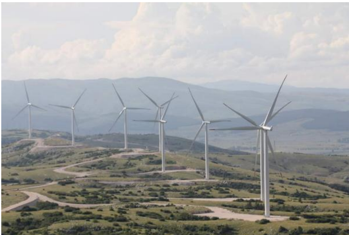
Sl. 44 Vjetroelektrana Mesihovina na Grabovičkoj zaravni
