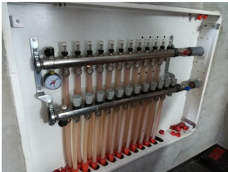
Slika 8. Sustav podnog grijanja u vodenom parku Aquae vivae (Preuzeto sa HGI-a; foto: I. Bobovečki)
