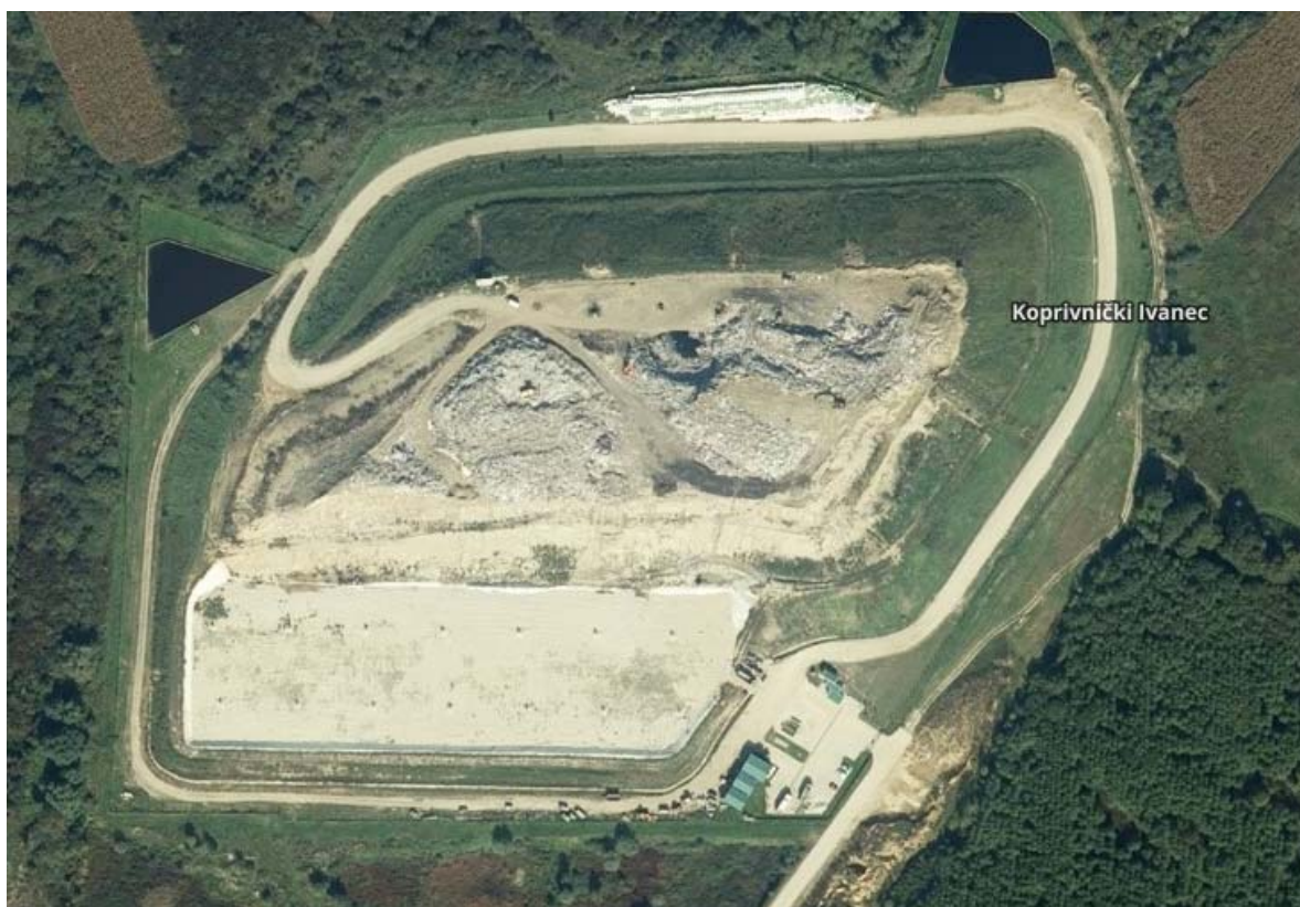
Slika 1. Izgled odlagališta otpada „Piškornica“ prema Geoportal, DGU, 2015.
