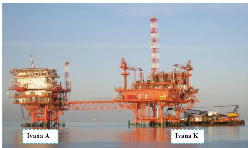
Slika 7.: Eksploatacijska platforma Ivana A i kompresorska platforma Ivana K (OPP istraživanja i eksploatacije ugljikovodika na Jadranu)
