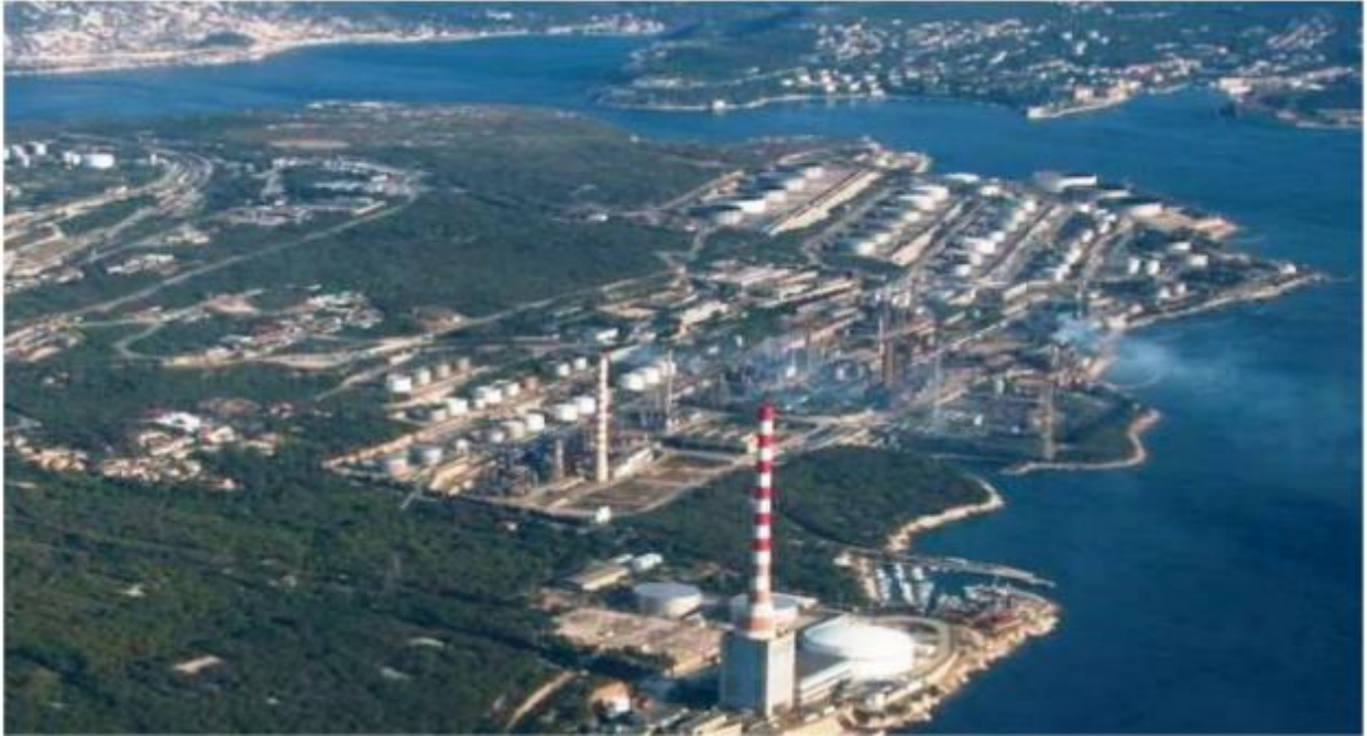
Slika. 8: Panoramski pogled na postrojenje Rafinerije nafte Rijeka
