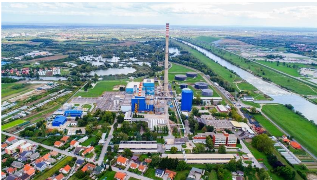
Sl. 3 Termoelektrana-toplana Zagreb i njena ustava desno na slici
