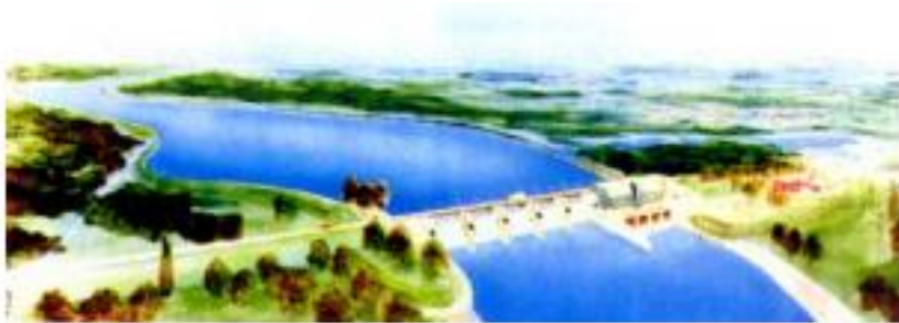
Sl. 11 Bazen i hidroelektrana sustava Podsused
