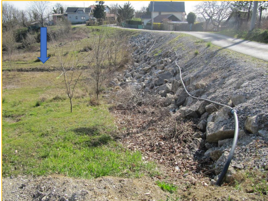
Slika 26. Podzemna vodovodna komunikacija, sanirana rastezljivim priključkom i ostavljena nadzemno, „šakanac“ (navezeni kamen) i odvodni kanal označen strelicom (fotografirano tijekom terenskog kartiranja 2020. godine)
