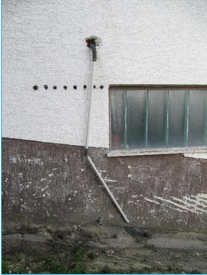
Photo- 222, 223,224, 4 (odvod iz kuće)
