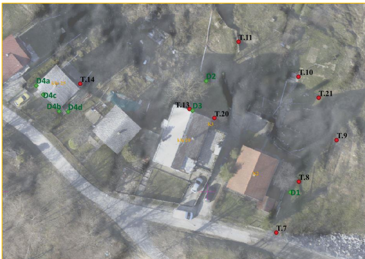
Slika 32. Čelo klizišta sa stambenim objektima (narančasto) na kojima su se vršila mjerenja (zeleno točke). Crvenim točkama su označene terenske točke pregleda terena.
