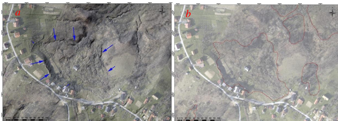
Slika 47. (a) Ortofoto s digitalnim elevacijskim modelom (DEM) visoke rezolucije (0,5 x 0,5 m). Plavim strelicama su prikazane izražene pukotine na modelu i terenu koje ujedno i omeđuju klizište. (b) Ortofoto s kabinetski iskartiranom granicom klizišta. Na terenu je granica klizišta korigirana do saniranog dijela ceste.
