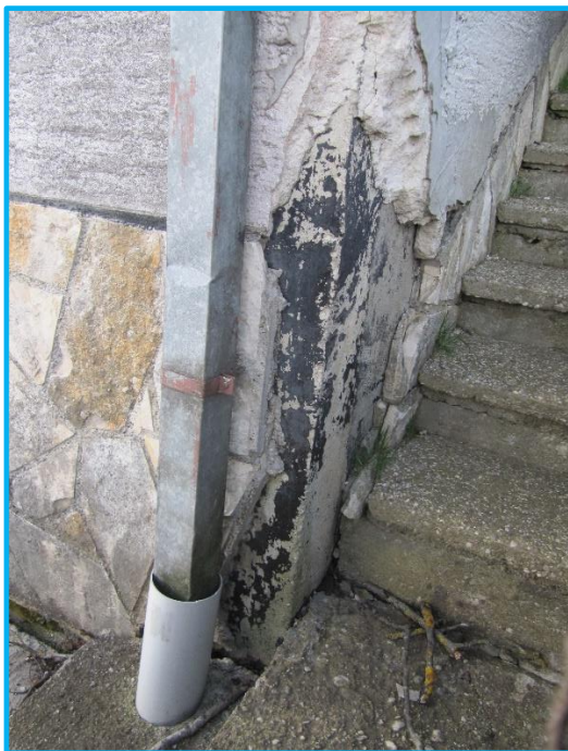
Photo 233,9-pogled iza kuće, gornji dio klizišta
