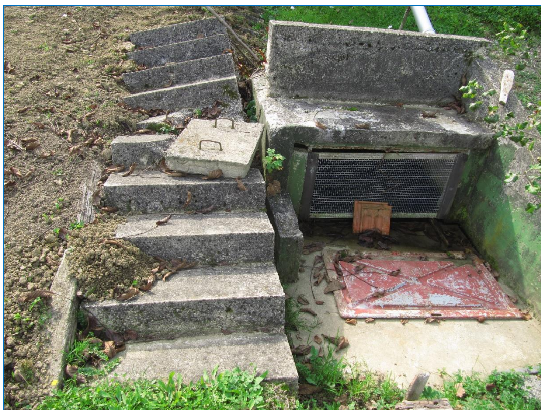
Slika 10. Primitivno kaptirani izvor, devastiran klizanjem terena (fotografirano tijekom terenskog kartiranja 2019. godine)
