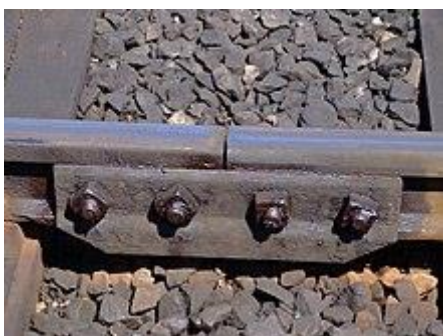
Slika 17. Primjer procijepa na tračnicama 56
