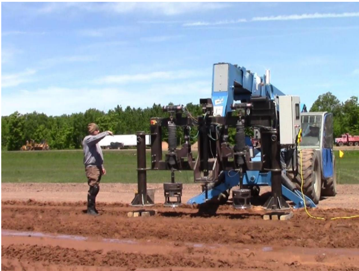
Sl. 17. Terensko mjerenje bevametrom montiranim na buldožer
