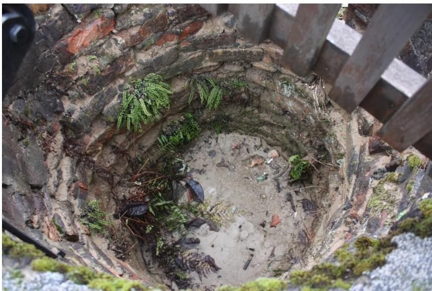
Slika 5. Bunar zatrpan sedimentom na lokaciji S66_1.
