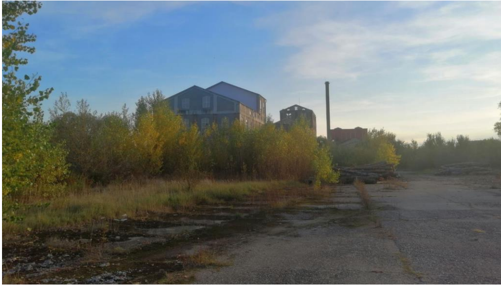
Sl. 36. Otvorena površina na mjestu srušenih skladišta (lijevo)
