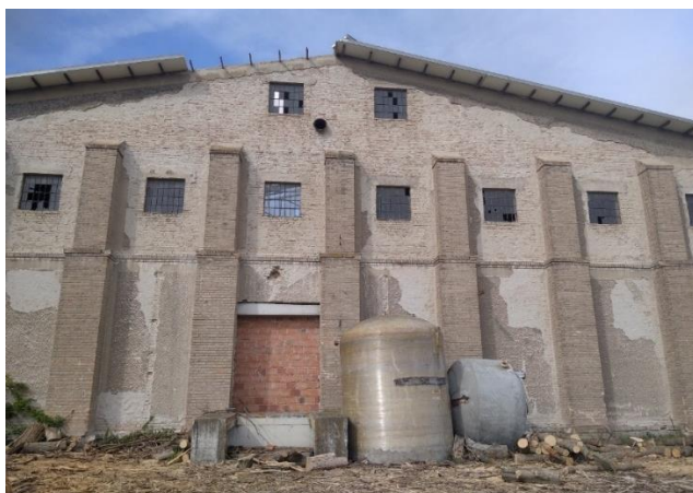
Sl. 33. Zgrada bivšeg skladišta šećera
