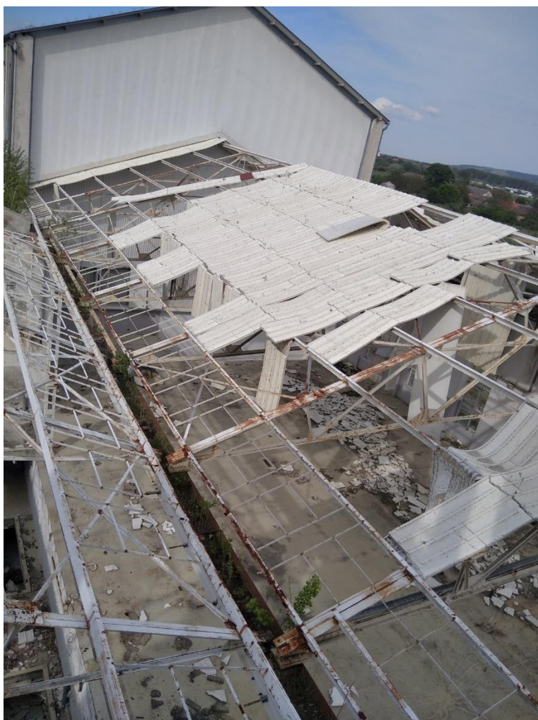
Sl. 35. Krovište proizvodnog pogona
