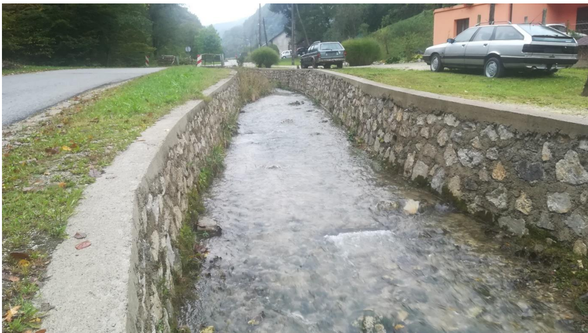
Sl. 29. Kamenom obzidane obale i izravnano dno na Breganici u naselju Breganica (snimila V. Curman, 09.10.2021.)
