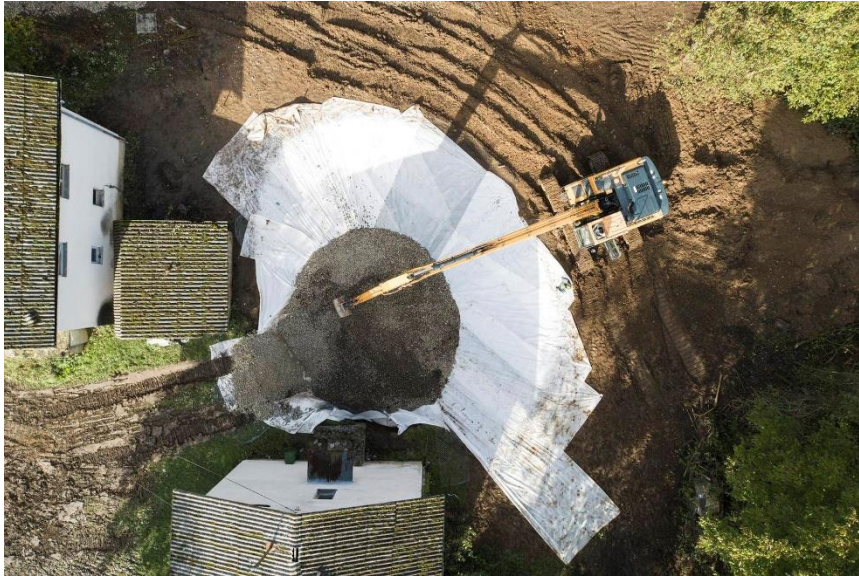
Sl.21. Sanacija vrtače u Mečenčanima
