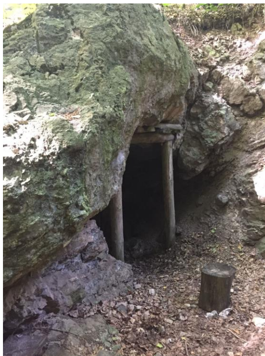
Slika 7: Drvena podgrada
