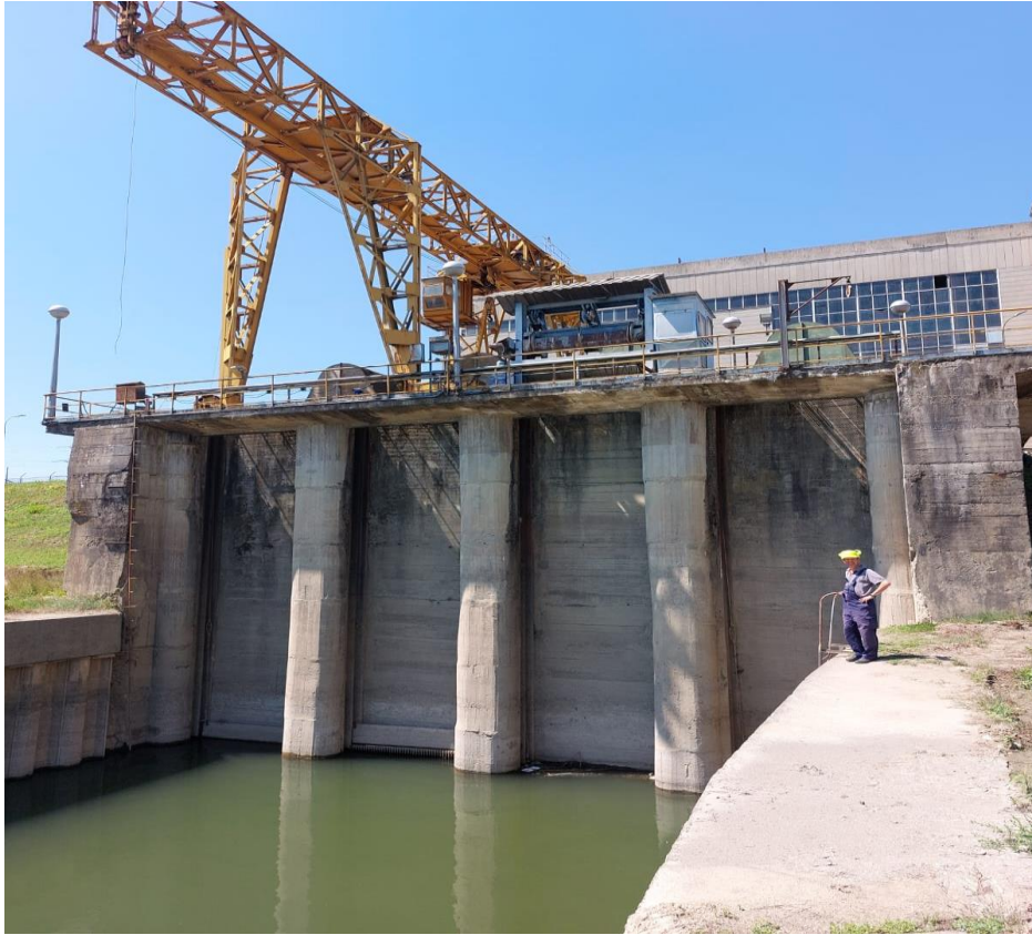
Sl. 4. Crpna stanica na vodozahvatu rijeke Save
