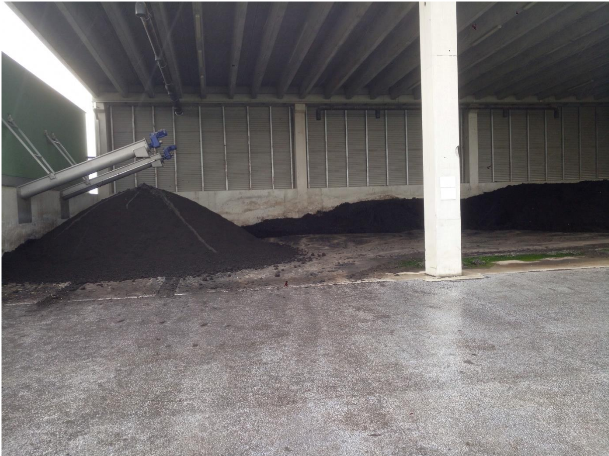
Slika 6. Dehidrirani mulj UPOV Karlovac.
