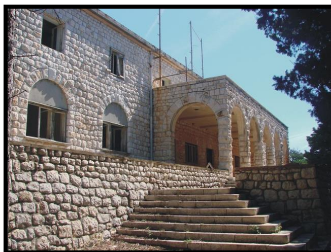
Sl. 34. Upravna zgrada
