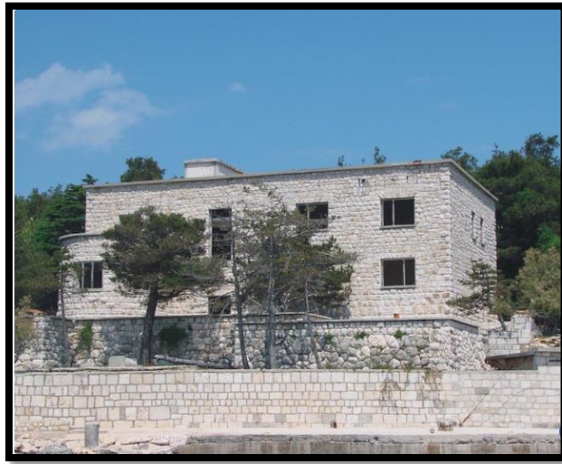
Sl. 35. Posjetna zgrada
