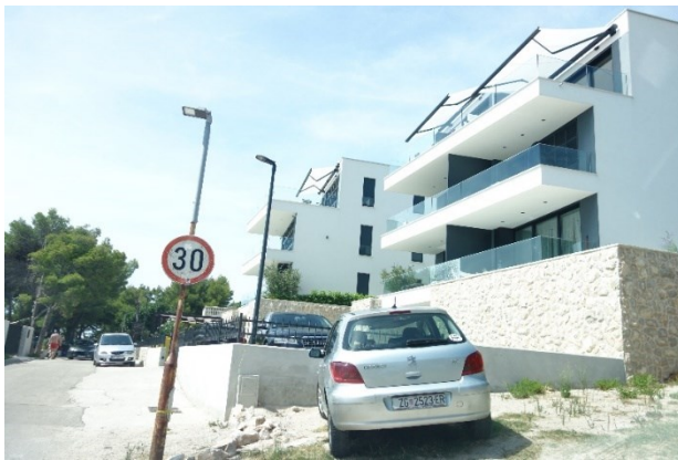
Slika 53. i 54. Izgradnja novih modernih vila nedaleko plaže Slanice
