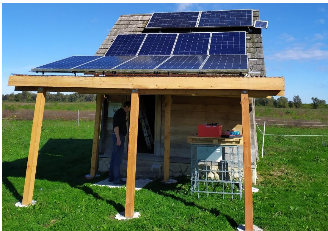
Slika 1.3 – Solarni paneli na krovu kontrolne kuće.
