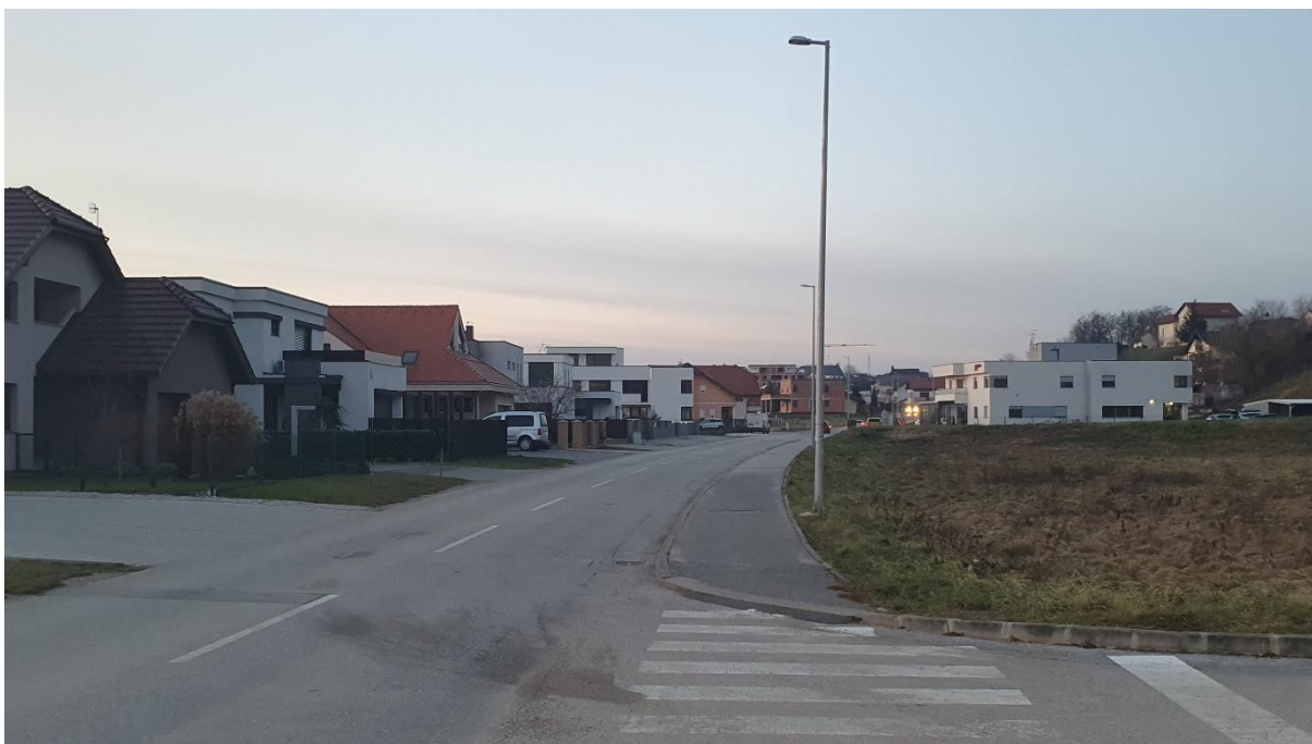
Sl. 27. Novoizgrađene obiteljske kuće u naselju Mihovljan Slikao: Bruno Makovec, 2023.
