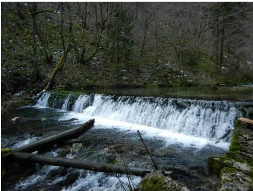
Sl. 16. Brana na izvoru potoka Plitvice zbog potrebe vodoopskrbe
