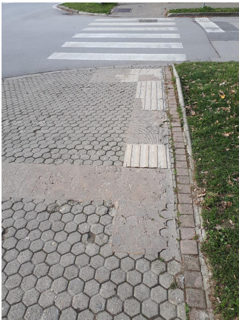
Sl. 15. Uništena taktilna polja i vodiči u Ulici Ivana Meštrovića Izvor: autorska fotografija
