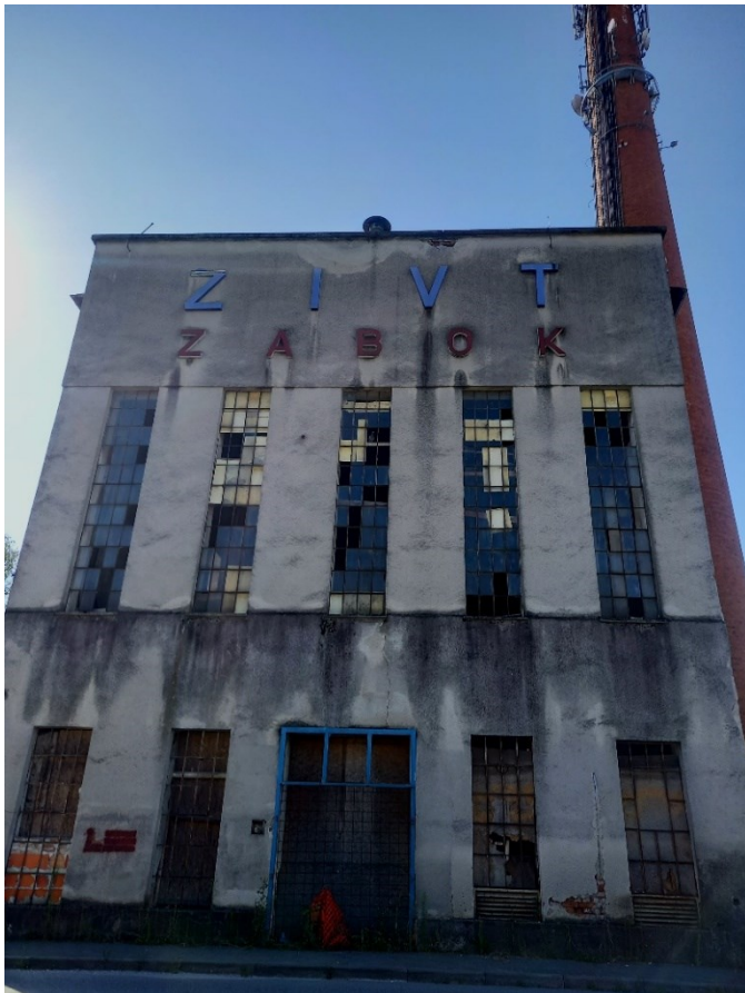
Sl. 14. Zgrada nekadašnje tvornice „ZIVT“ 2023. godine Izvor: autorska fotografija, 2023
