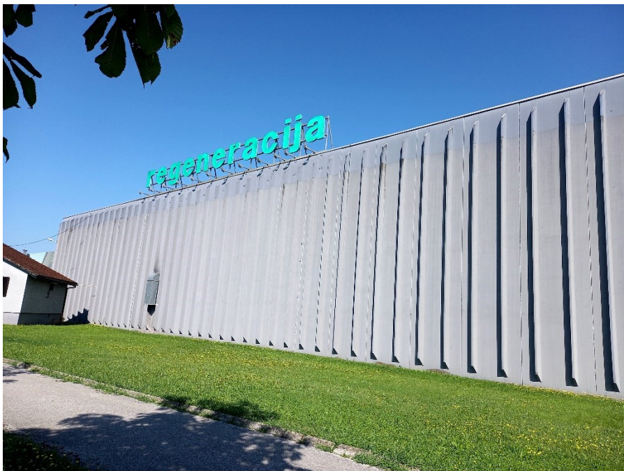
Sl. 15. Zgrada tvornice „Regeneracija“ 2023. godine Izvor: autorska fotografija, 2023
